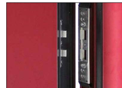
Pièces anti-dégondage pour empêcher le soulèvement de l'ouvrant lors d'une tentative d'effraction
